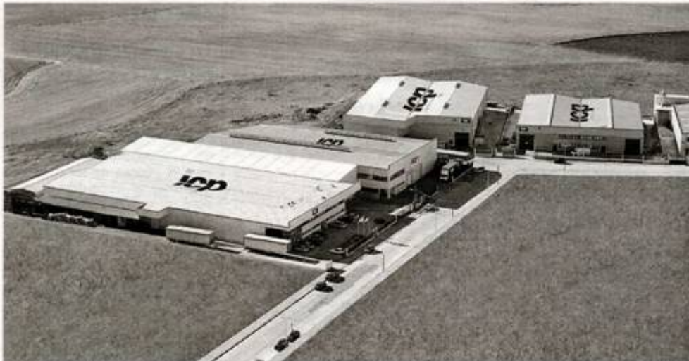
VISTA AÉREA de las instalaciones de ICP Logística en el término municipal de Alcalá de Henares (Madrid).
